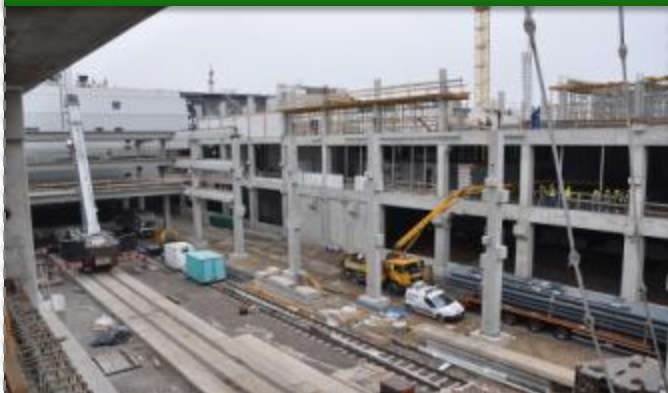
Montaż konstrukcji w nocy
