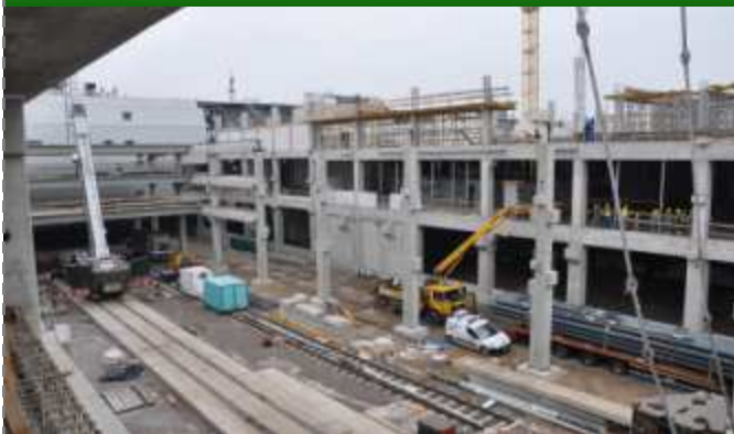
Montaż konstrukcji w nocy
