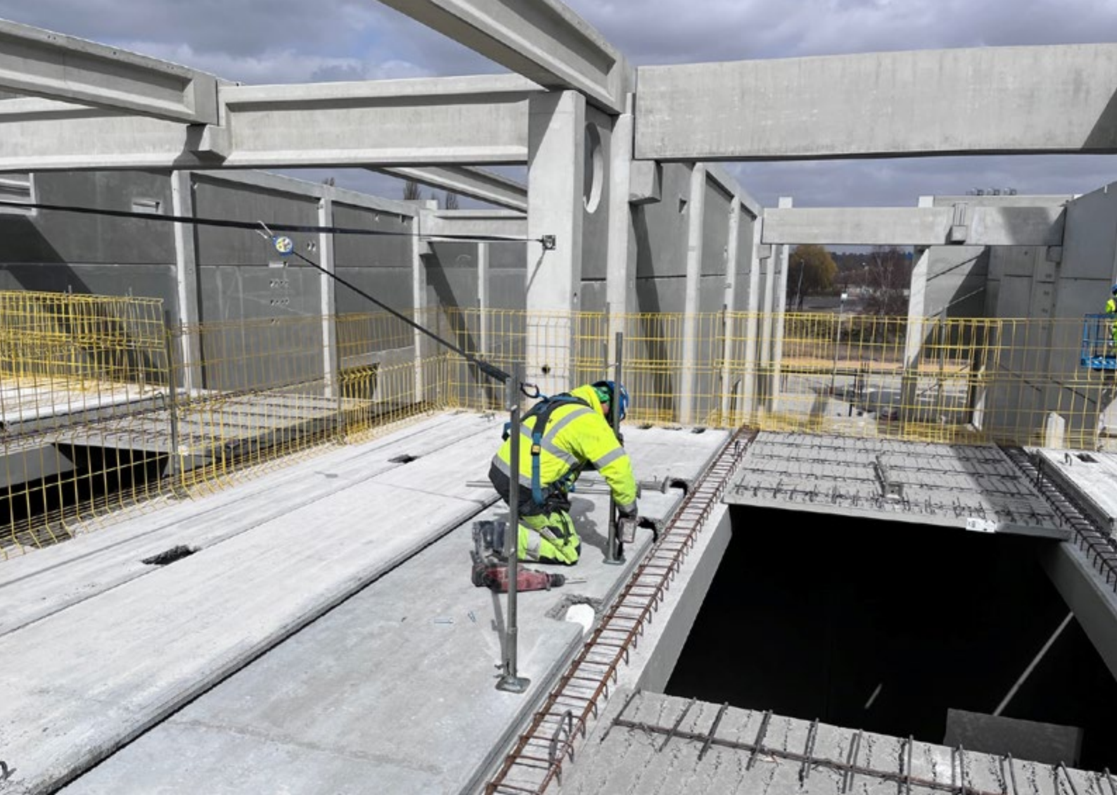
Pracownik Działu Montażu na budowie
