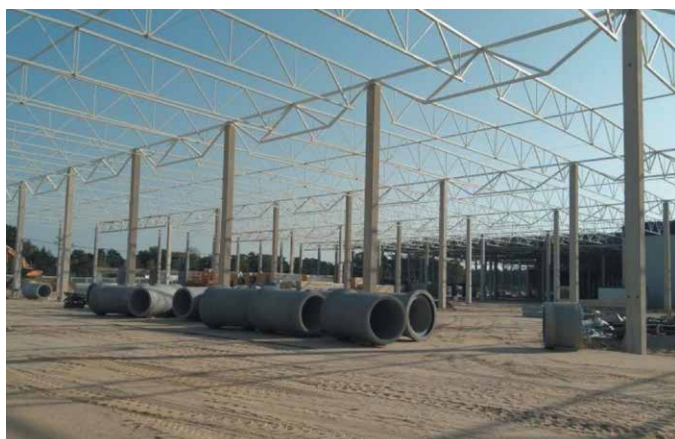
fot. 3. Dach hali wykonany w technologii prefabrykacji stalowej [S5]
